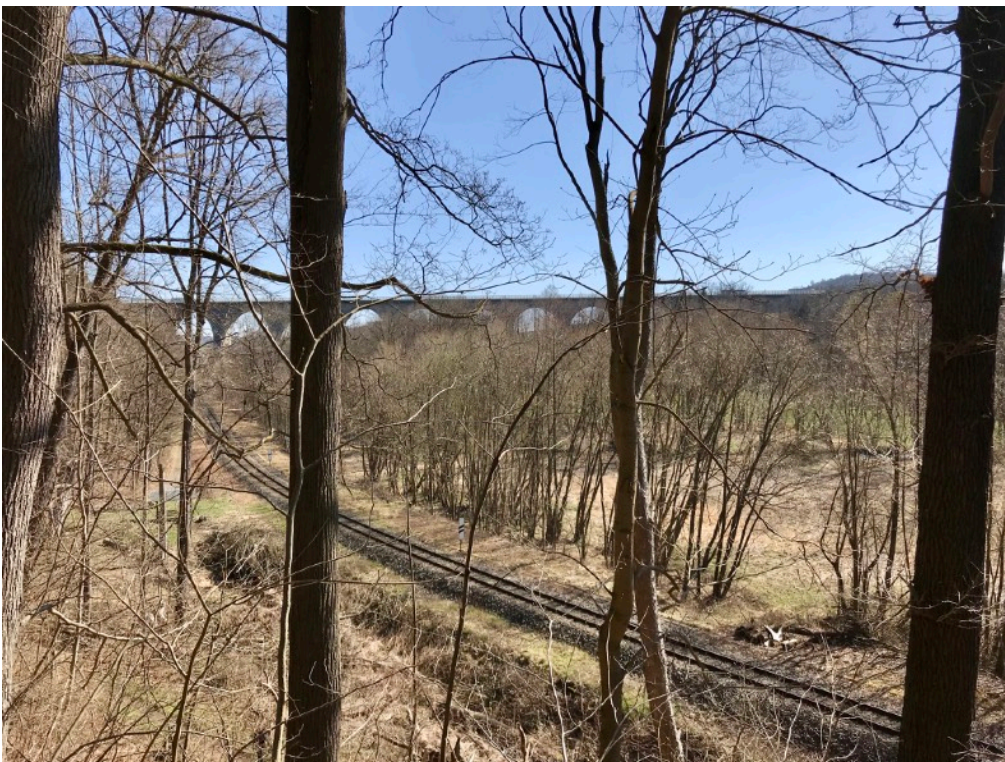
Blick vom Sichelgrund auf die „Weißer-Elster-Talbrücke-Burgstein-Pirk“
